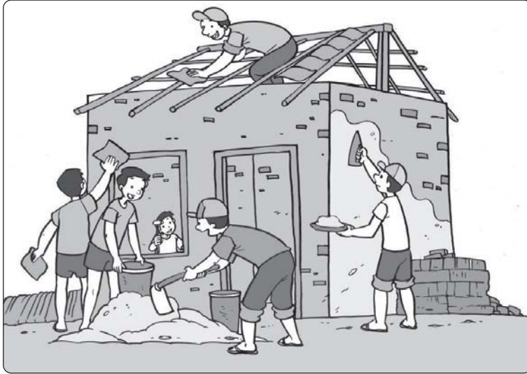
Gambar: Gotong royong untuk memperbaiki Balai Desa
