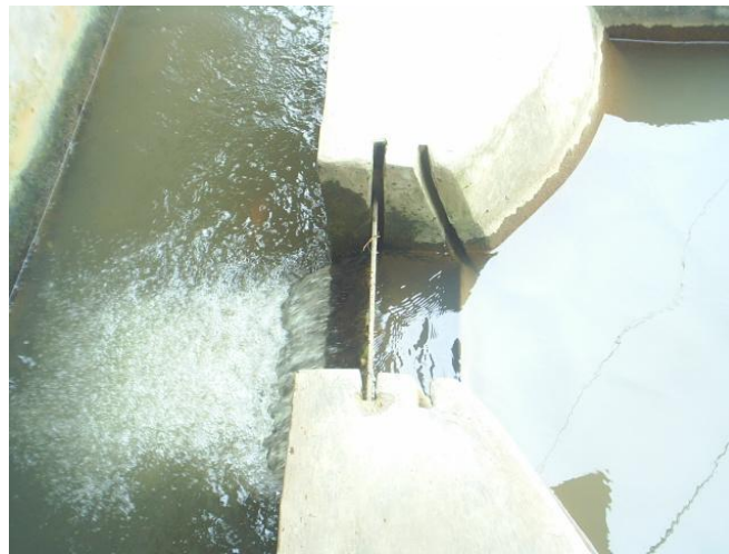
Gambar 11. Pintu pengeluaran air tipe Monik.
