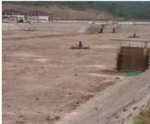
Gambar 41. Mengapur dasar kolam/tambak
