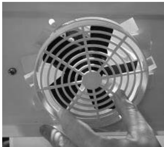
Gambar 2.3 Motor Fan Evaporator
