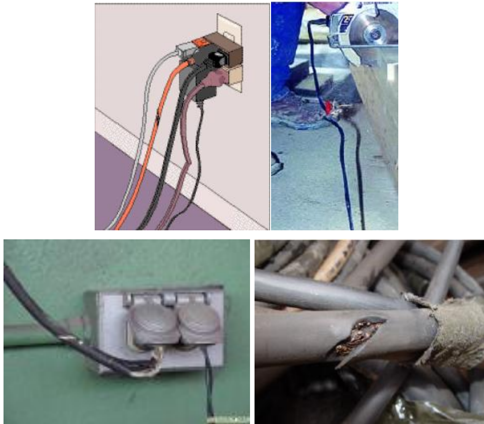
Gambar 1.1 Kondisi Yang Membahayakan
