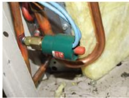
Gambar 5.15 High-pressure Switch pada Unit Tata Udara Domestik
